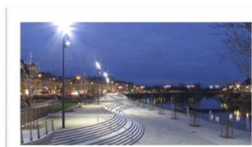
Eclairage public et voirie
